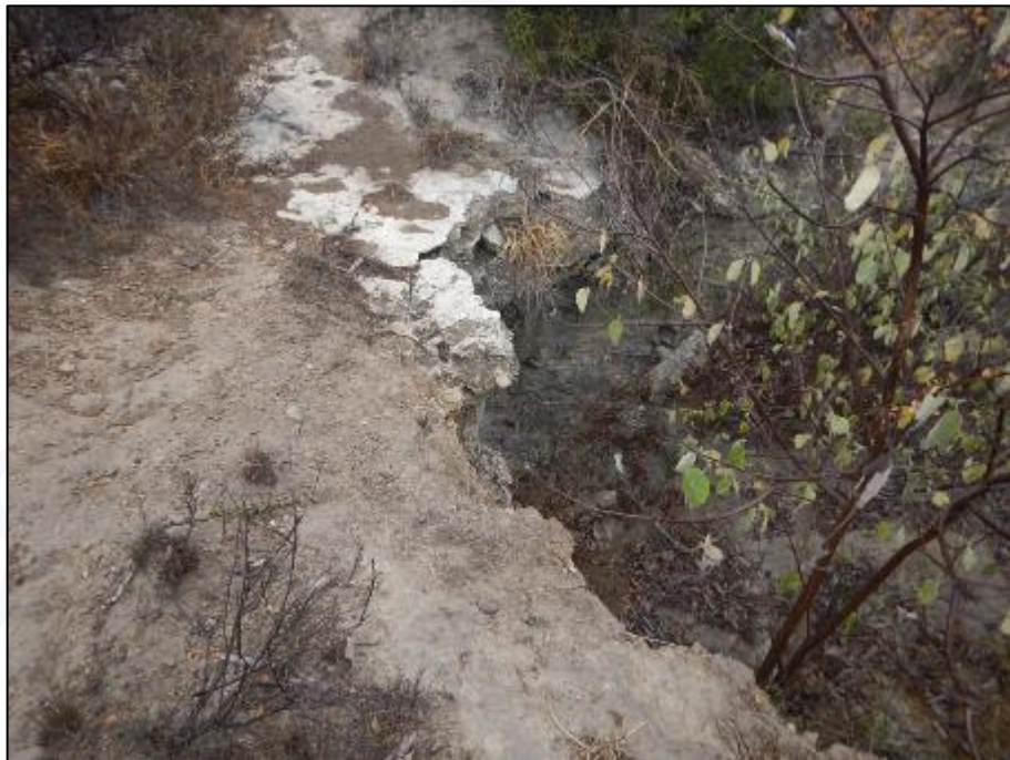
Figura 7-3 Corte abrupto formando una carcava como inicio de los arroyos .
